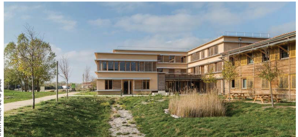
Pépinière d'entreprises + extension = locaux CCVD - Eurre
