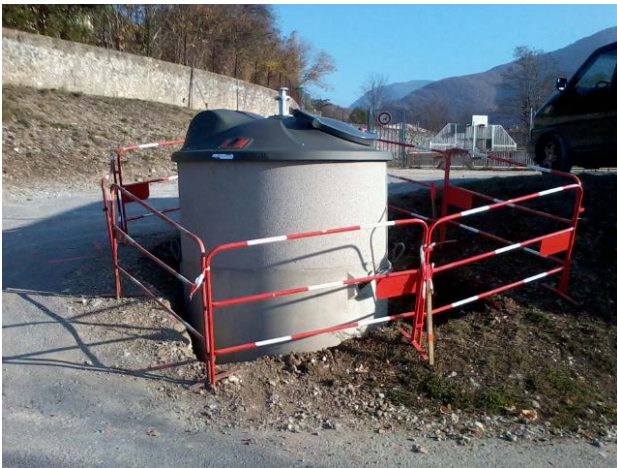
Installation du CSE à l'entrée du city-stade
