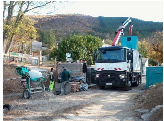
Travaux de terrassement préparatoire pour les futurs containers semi-enterrés (CSE) du boulevard de l'Echo
