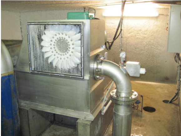
Turbine de Tignes suite visite
