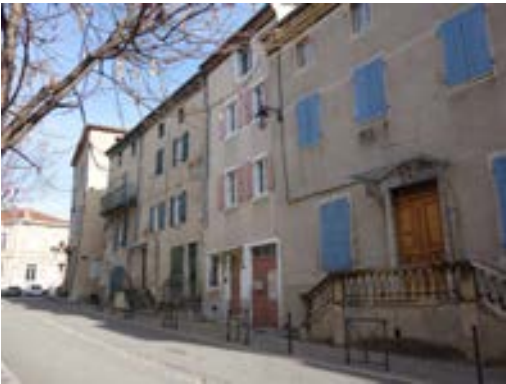
maison de bourg et ruelles
