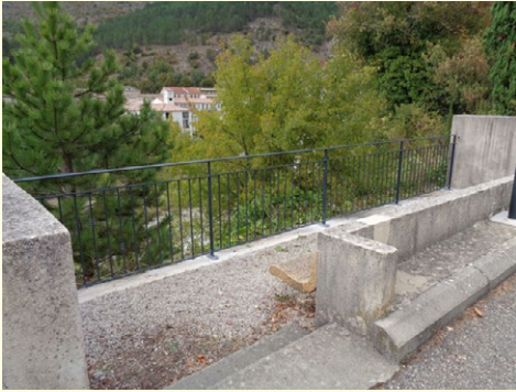
Nouveau garde-corps, chemin d'accès aux Samarins
